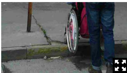
Il marciapiede non ha lo scivolo
