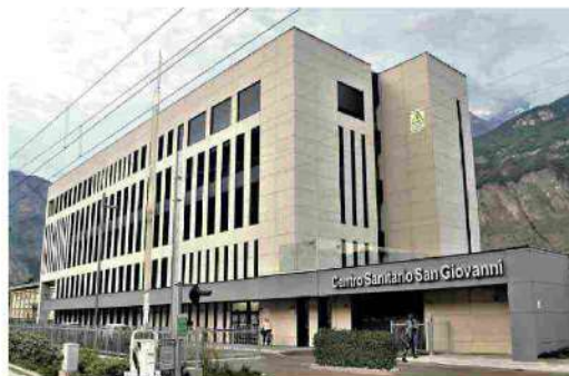
Il Centro Sanitario San Giovanni Mezzolambardo (Trento) è il primo in Italia certificato LEED Italia v3 - LEED 2009 con rating Platinum, la classificazione di sostenibilità del costruito più elevata prevista dal protocollo
