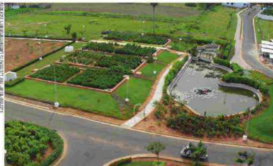
Dal 2003 l'Aravind Eye Hospital (Puducherry, India) dispone di un impianto di trattamento dei reflui con filtri piantunati e stagno naturalizzato, per il recupero dell'acqua a usi irrigui e il riuso dei fanghi mediante compostaggio
